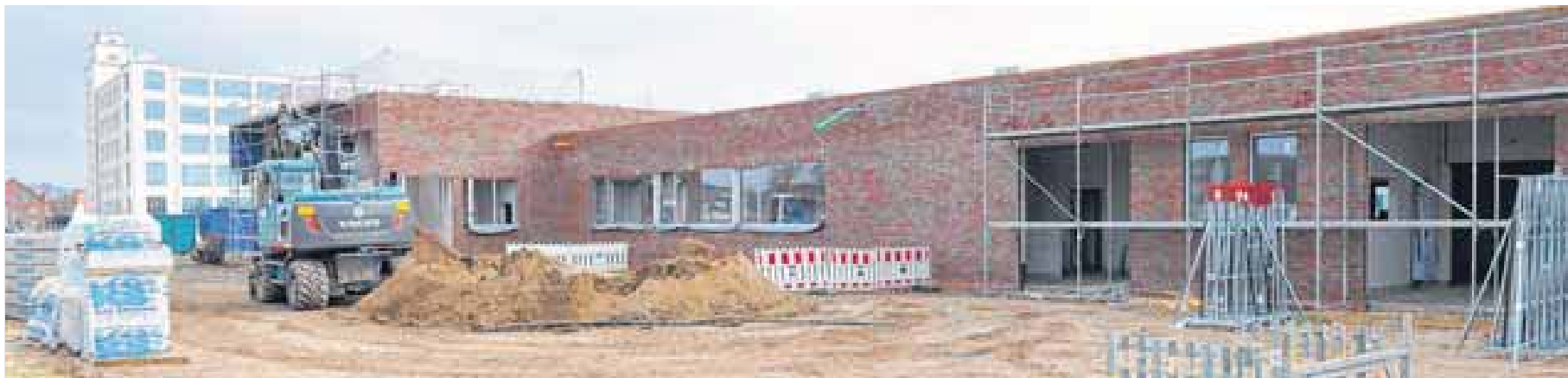
Im September soll die neue Großküche auf dem Nino-Areal ihren Betrieb aufnehmen. Sie ist die erste Ansiedlung im NINO-Wirtschaftspark. Foto: Westdörp
