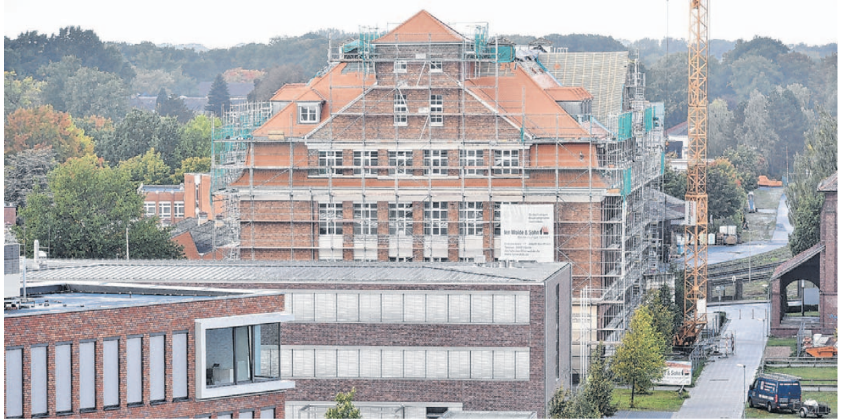
Blick auf die eingerüstete VHS, die energetisch saniert wird. Auf dem Gelände könnte ein Neubau entstehen.
