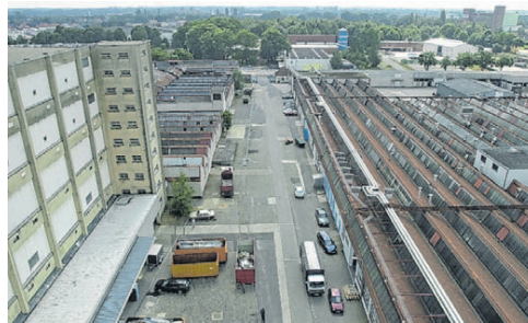
Es war einmal: Auch vier Jahre nach dem Ende von NINO zeigt der Blick entlang der ehemaligen Fabrikstraße noch das typische Gesicht der ehemaligen Textilfabrik mit dem Spinnereihochbau (links), eingrahmt von den Sheddachhallen der Spinnerei und der Veredlung. (Foto vom August 2000.) Foto: GN-Archiv
