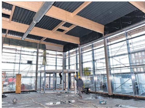
Lieferverzögerungen – unter anderem für die großen Leimholzträger der Foyerdecke – haben den Bauzeitenplan für das Kinozentrum durcheinandergewirbelt. Foto: Kersten
