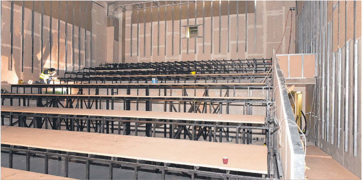
Im größten Saal des künftigen Kinozentrums läuft der Innenausbau auf Hochtouren. Zurzeit wird die stählerne Unterkonstruktion für die 150 vielfach verstellbaren Komfortsessel aufgebaut. Sie schafft unter den Füßen der Kinobesucher Platz für die Klimatechnik und die aufwendige Sitzelektrik. Foto: Kersten
