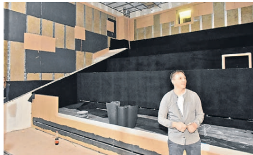
Die treppenartigen Zuschauertribünen sind fertig, die Wand- und Deckenverkleidungen entstehen gerade.
